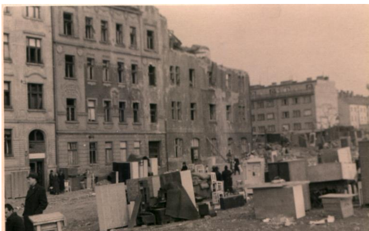
Bombardováním poškozená budova nemocnice
